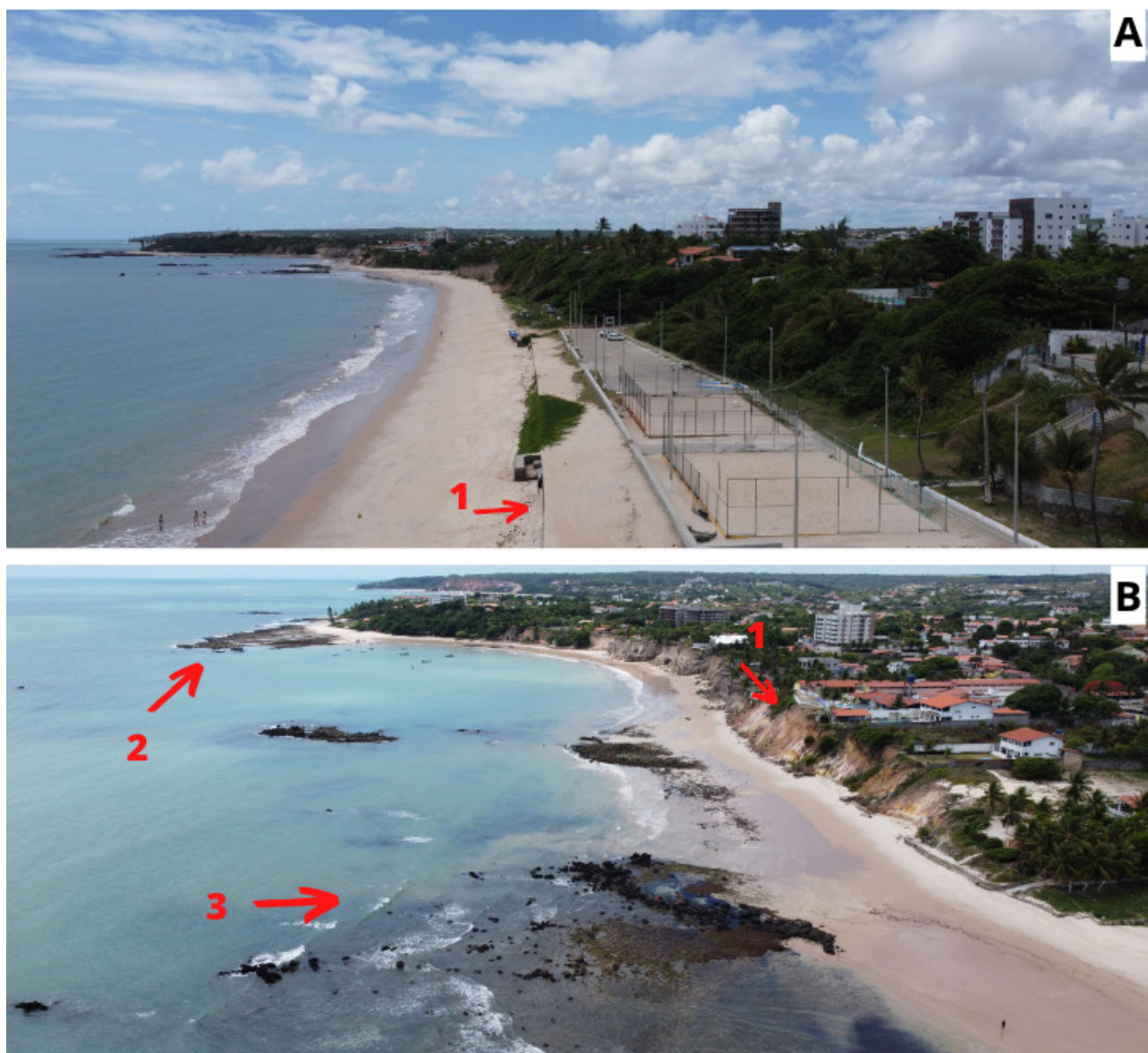
FIGURA 5: Imagens aéreas (drone) da praia de Jacumã e Carapibus. A) Praia de Jacumã, praça do mar à esquerda 1- contenção de concreto; B) Praia de Carapibus 1- Ocupação humana nas margens da falésia, 2 e 3 - afloramento calcário ( beachrocks ). Autodescrição: fotos aéreas de praias sinalizando erosão costeira
