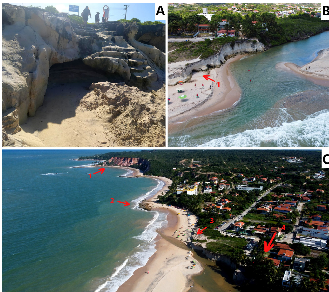
FIGURA 6: Detalhes da praia de Tabatinga II. A) Erosão por ação antrópica, com a construção de uma escada na própria rocha e por causa natural, formando uma cavidade na parte inferior do terraço; B) Foto aérea do terraço de frente 1- detalhe para erosão que se forma cavidades na parte inferior do terraço e a livre circulação de pessoas na superfície; C) Foto aérea da praia 1- falésias ativas, 2- afloramento de rocha calcária, 3- ponto de observação, 4- ocupação humana sobre o terraço, muito próxima da escarpa. Autodescrição: fotos aéreas de praias sinalizando erosão costeira.
